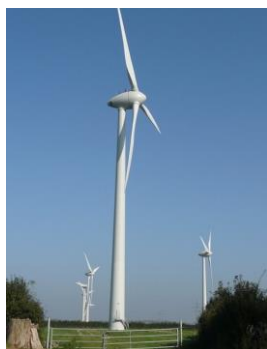
Parc éolien de Nibas 1
